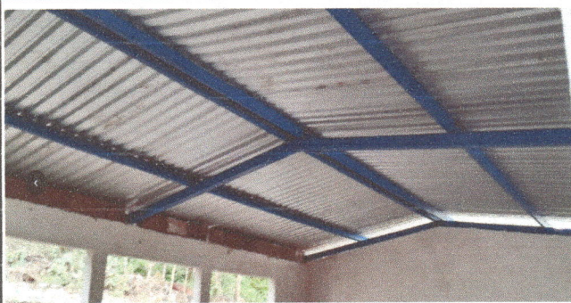
Foto 3: Vista durante la instalación de portante de techo
