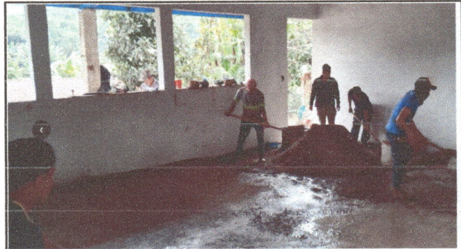
Foto 4: Sustitución de piso a piso de concreto alisado gris
