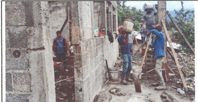
Foto 6: Sustitución de columnas de corredor y esquineras.
