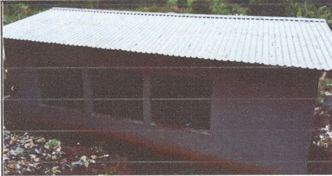
Foto 1: Vista actual del techo con láminas troqueladas
