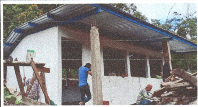
Foto 2: Sustitución de paredes y columnas.
