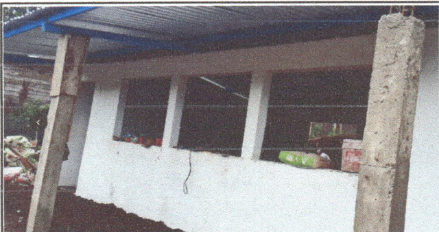
Foto 5: Sustitución de ventanales de madera a metales y vidrios.
